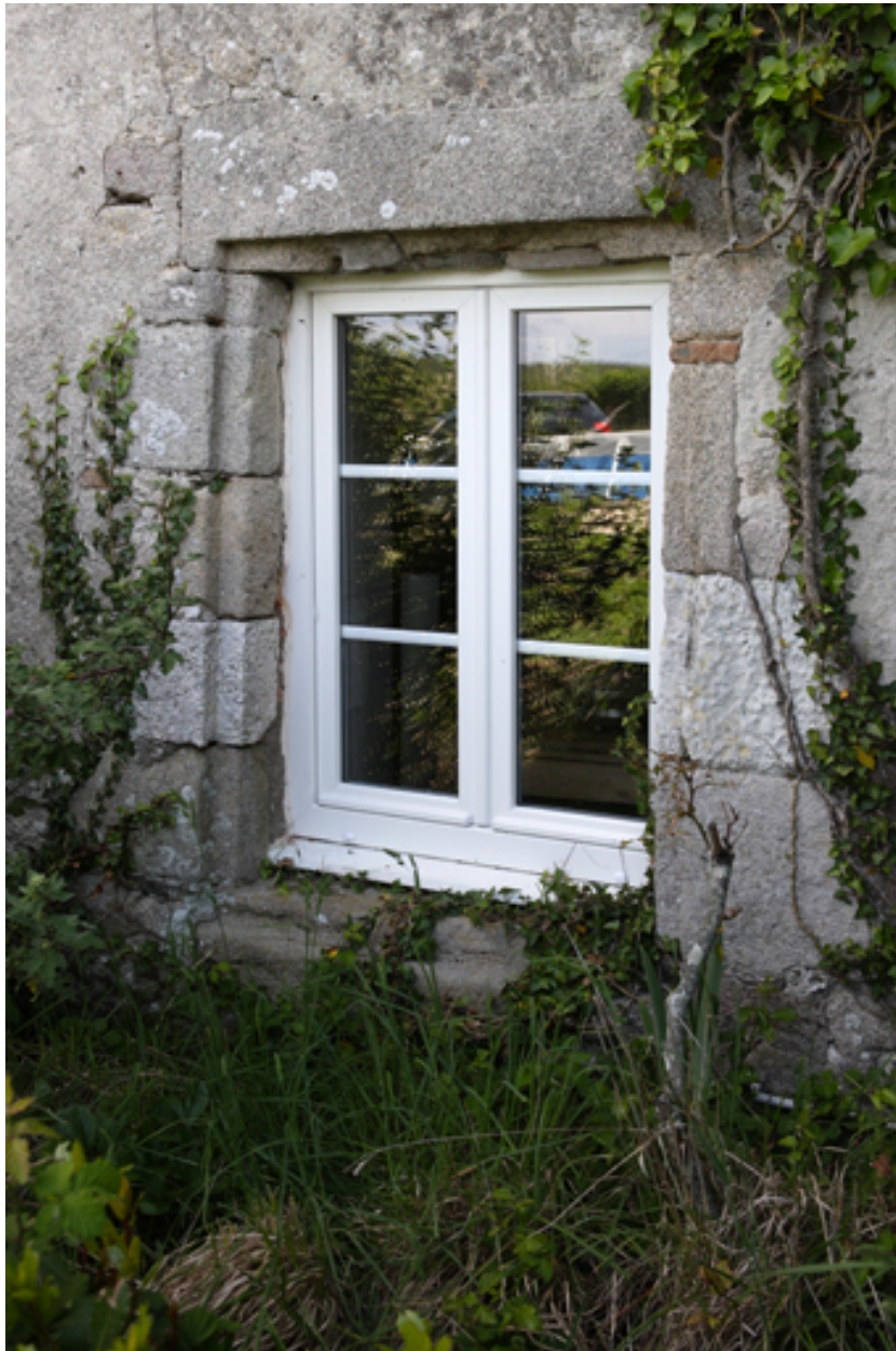
Logis. Façade sud. Partie est. Détail de la baie du rez-de-chaussée.
