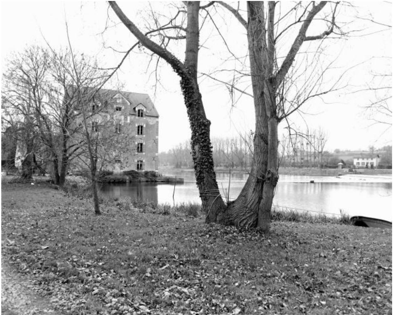
Vue d'ensemble du site depuis la rive gauche en amont : ancien et nouveau moulin (façade nord), barrage, pertuis, maison éclusière.
