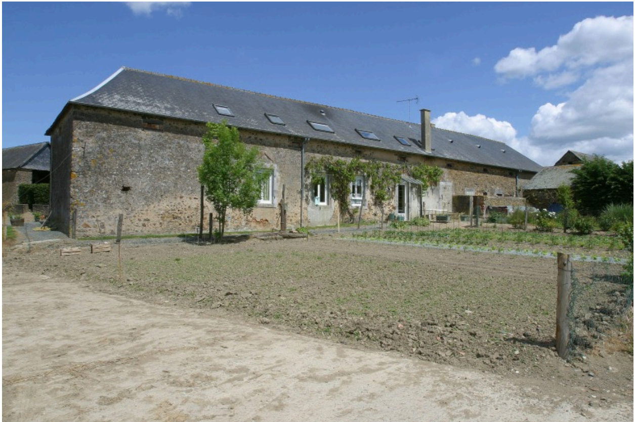
Le logis. Façade postérieure.
