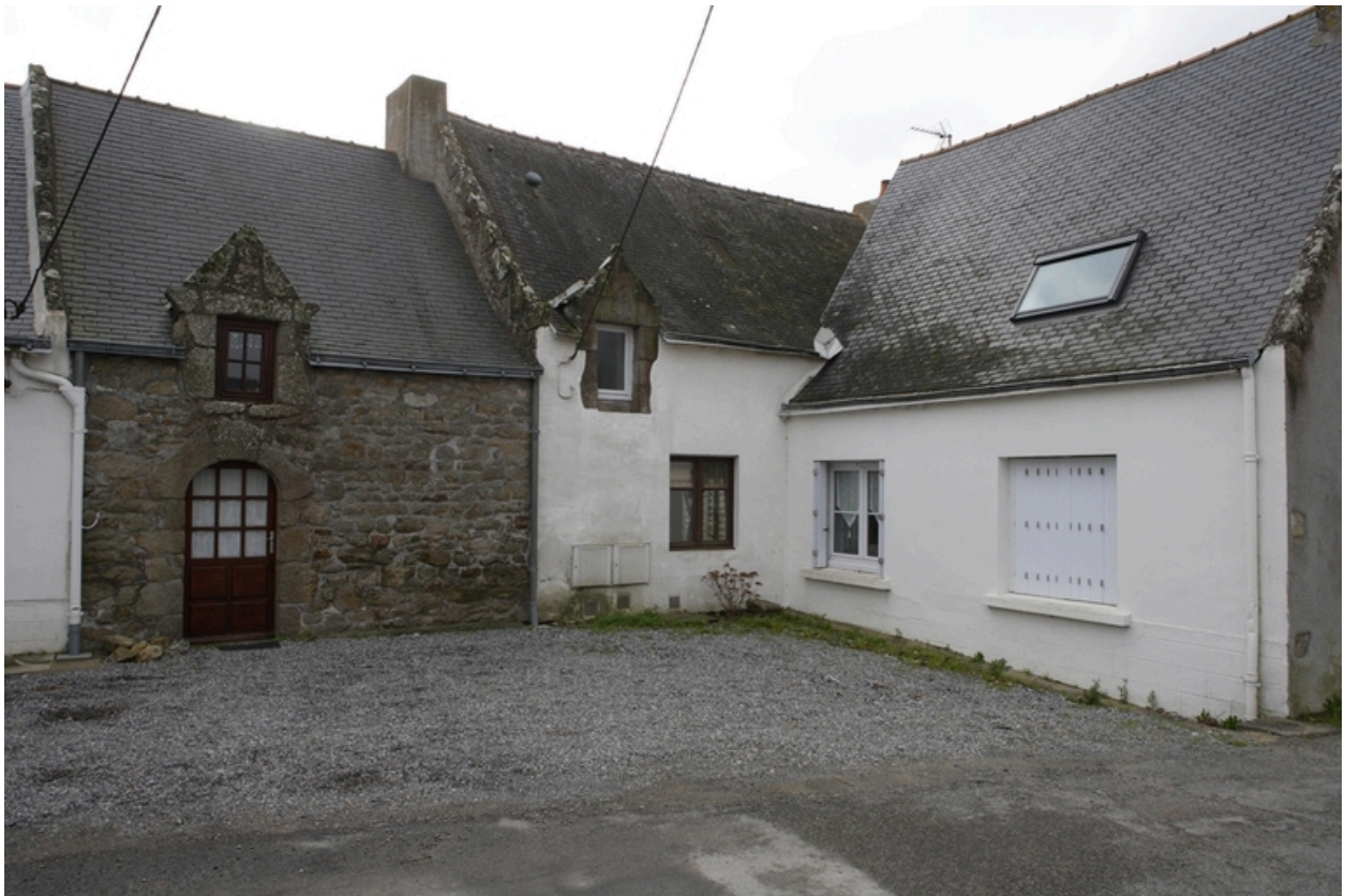
Vue des n° 2 et 4 rue du Rigouic.
