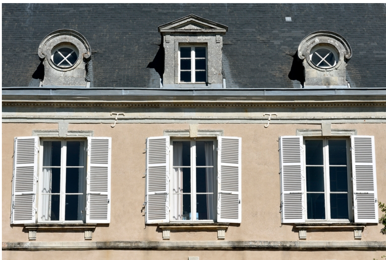
Façade sud. Détail des baies de l'étage et du comble.
