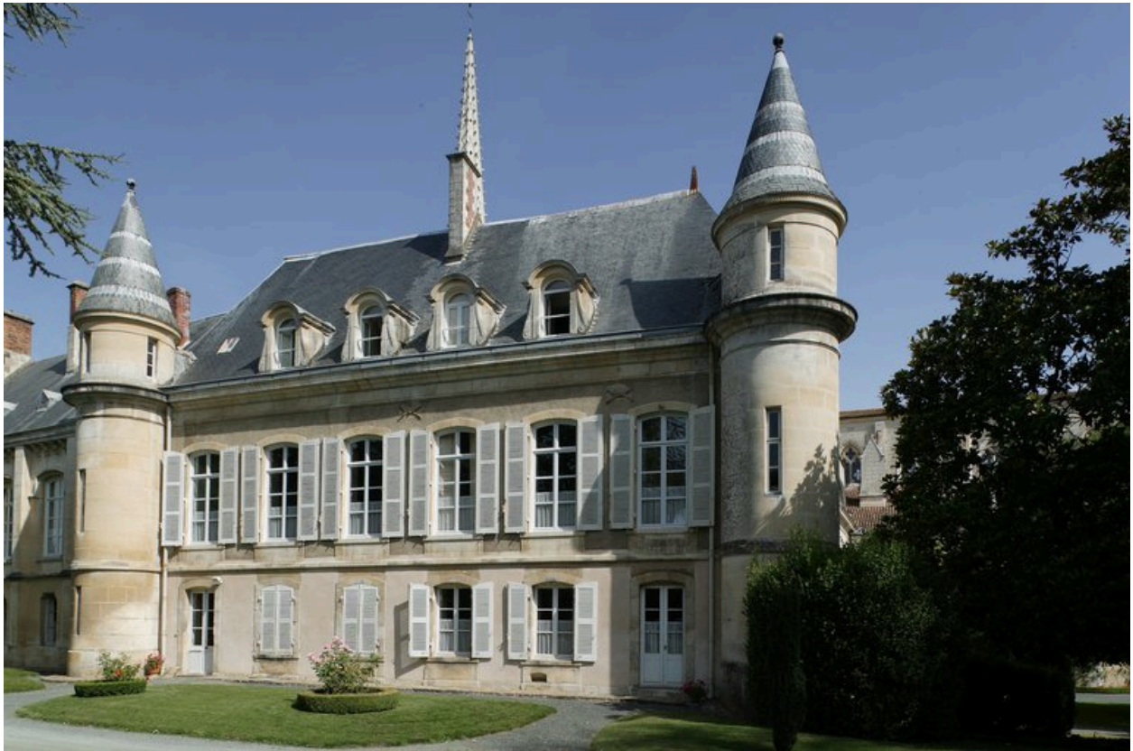
Bâtiment sud : vue prise du sud-est du corps de bâtiment est, datant du XVIIIe siècle et repris par Lisch.
