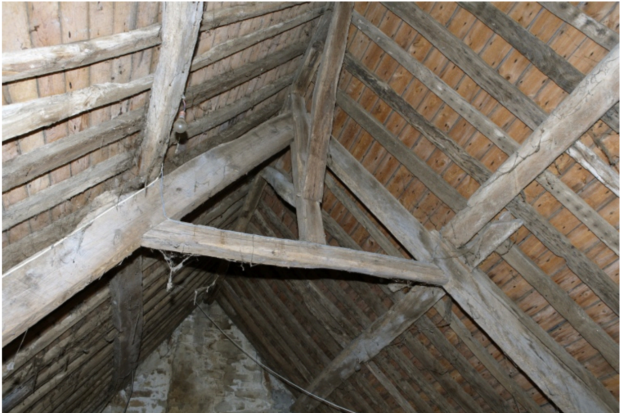
Vue de la charpente du quatrième logis (8 rue de la Riandouille).
