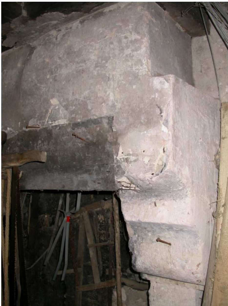
Chambre du meunier, cheminée XVIe siècle : piédroit.
