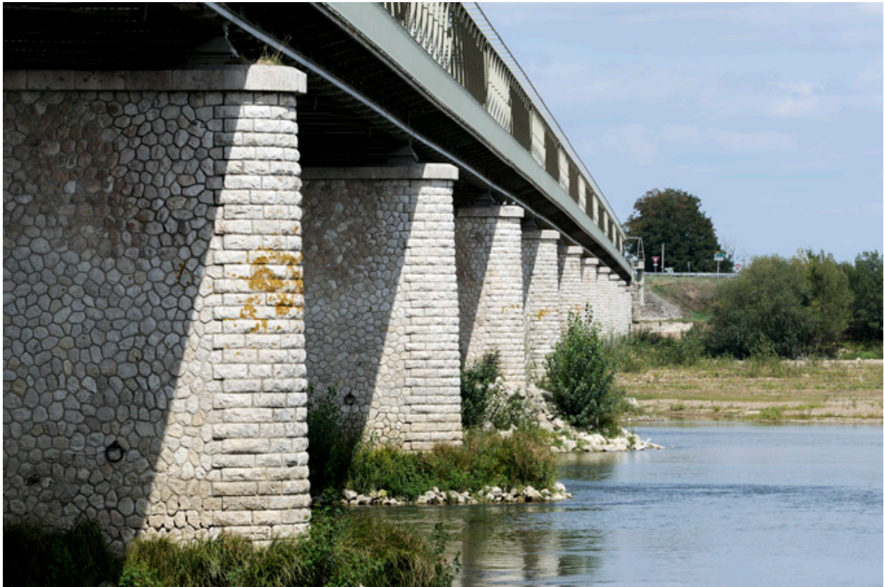
Face est du pont, depuis la berge
