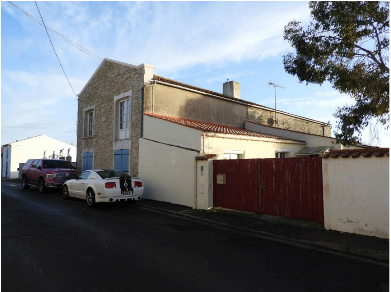
La maison, ancienne grange monastique, vue depuis le sud-ouest.
