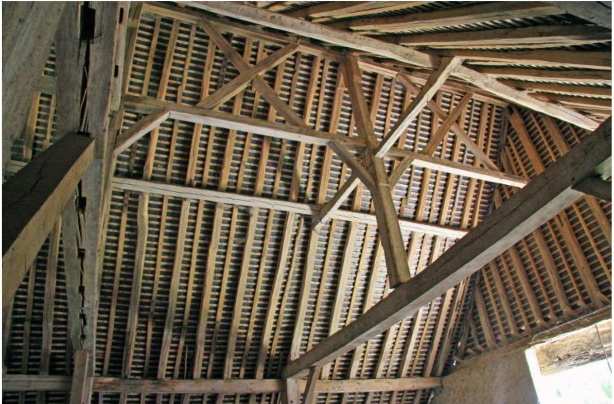
La grange : charpente à pannes, avec sous-faîtage et faux entrants à encoches pour les pannes.
