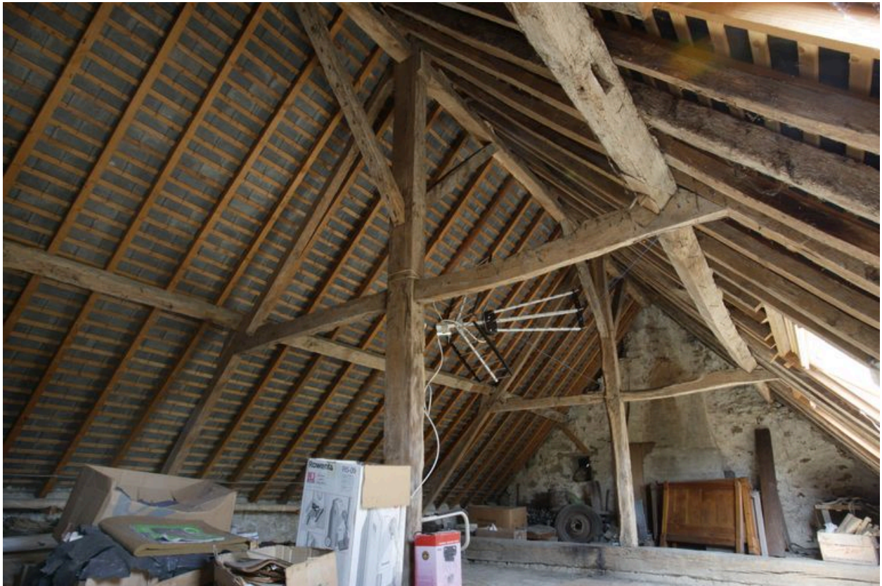
La charpente de la partie nord du logis.
