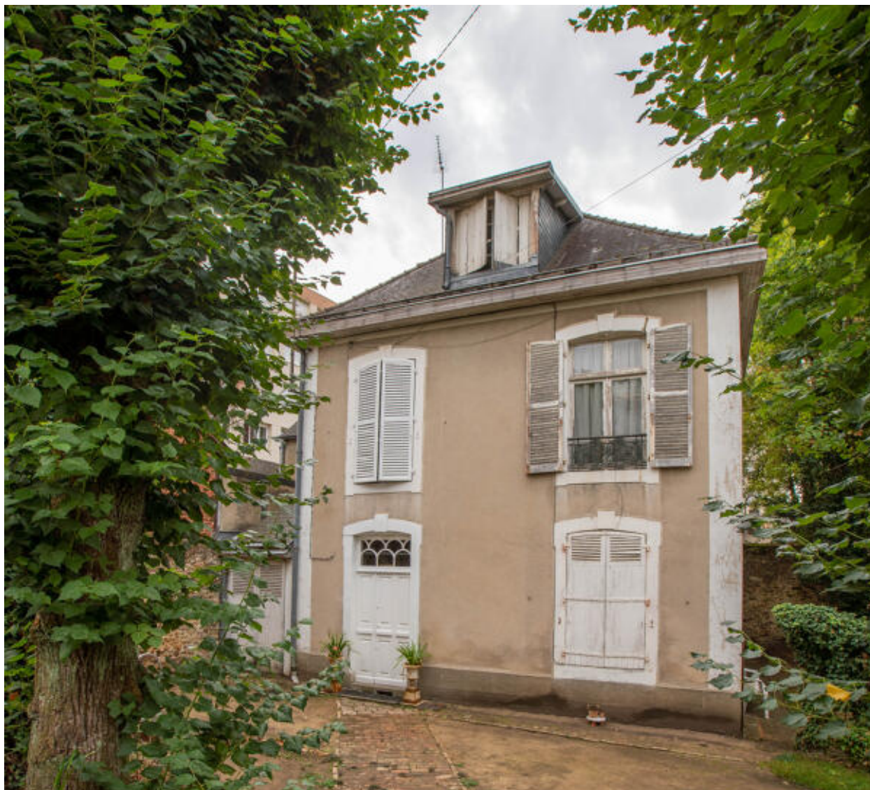
Vue de la façade d'entrée de la demeure rue Louis-Crétois et avenue Jean-Jaurès donnant sur l'Huisne.
