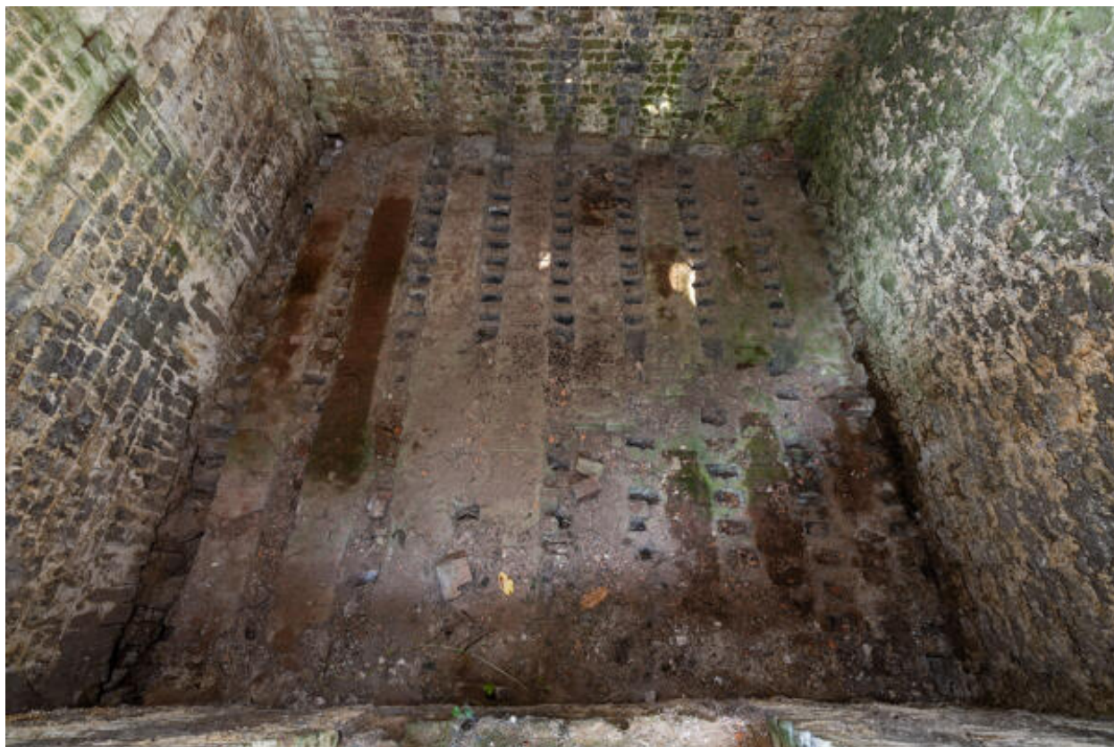
Le four : intérieur de la chambre de cuisson, sole.
