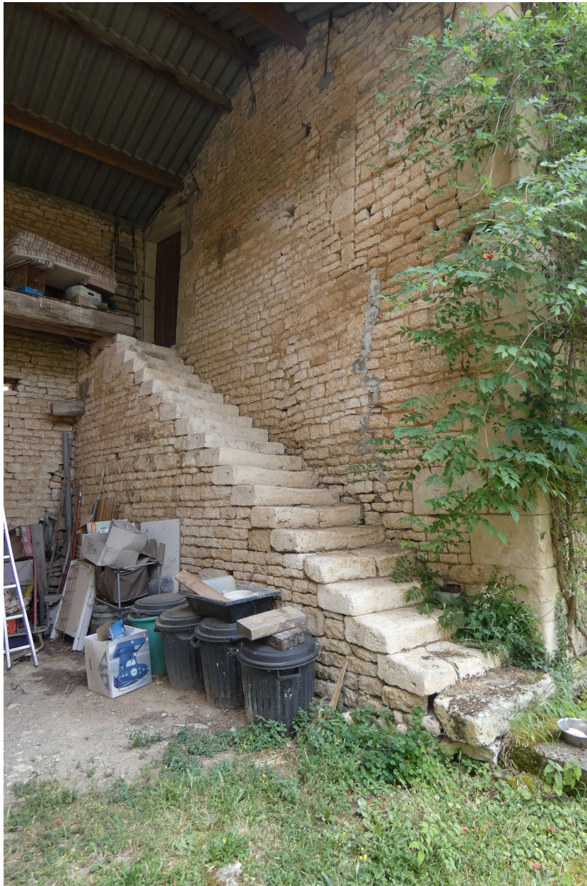
L'escalier extérieur conduisant à l'étage de l'aile est.
