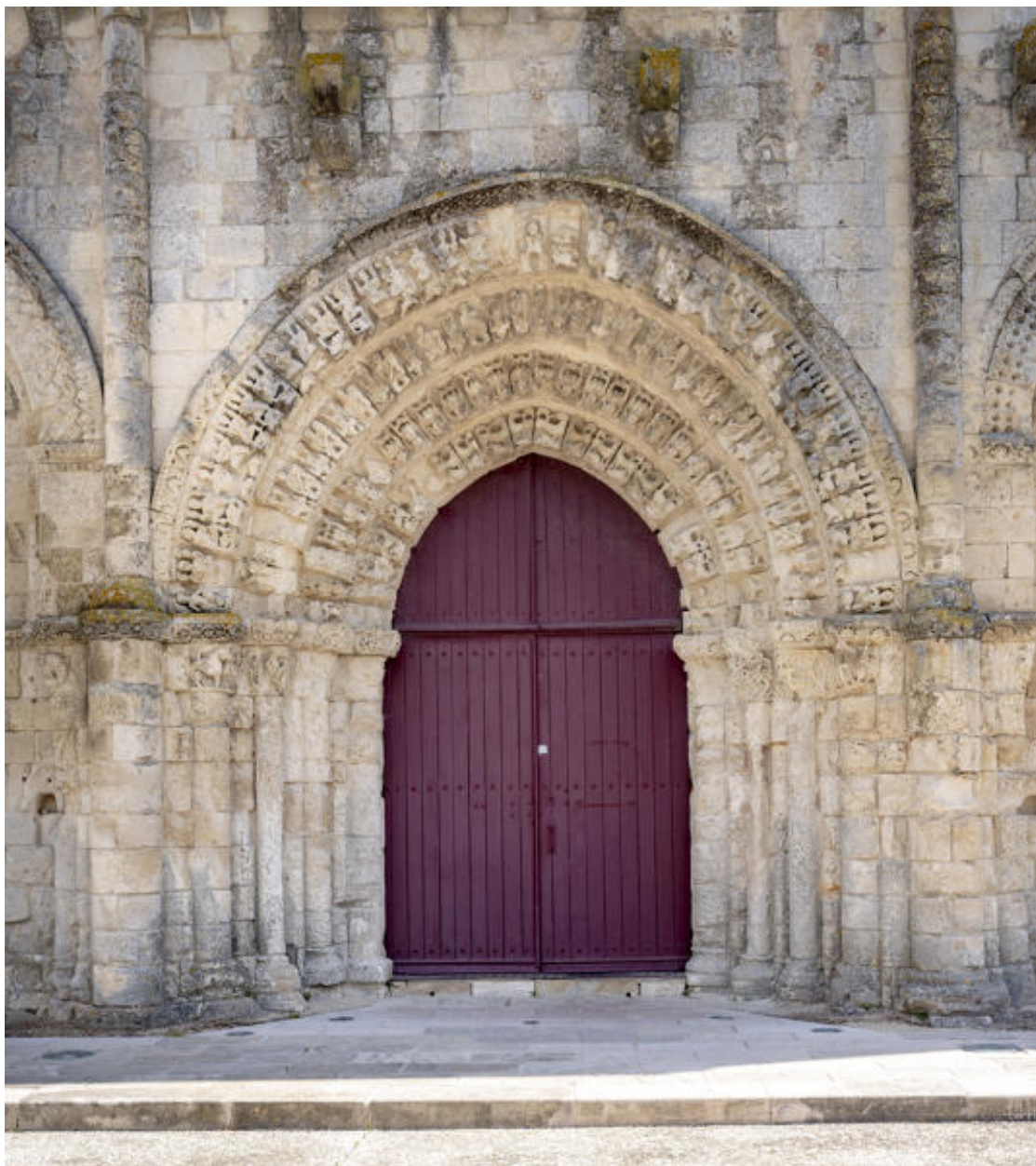
Détail du portail occidental.
