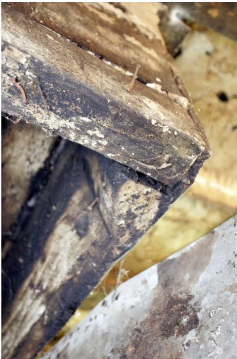
L'ancien logis-étale : détail d'assemblage du manteau de la cheminée.
