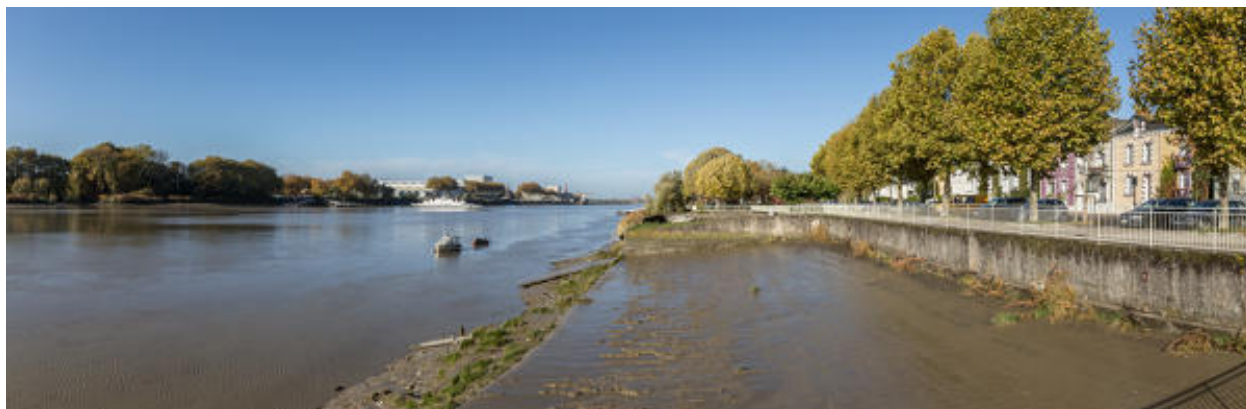
Gare d'échouage au droit du quai Henri-Brunais.
