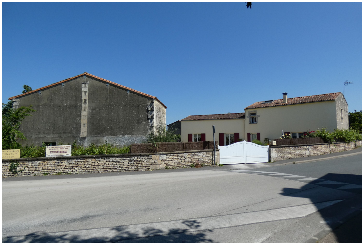
Le Nac vu depuis le sud-ouest.
