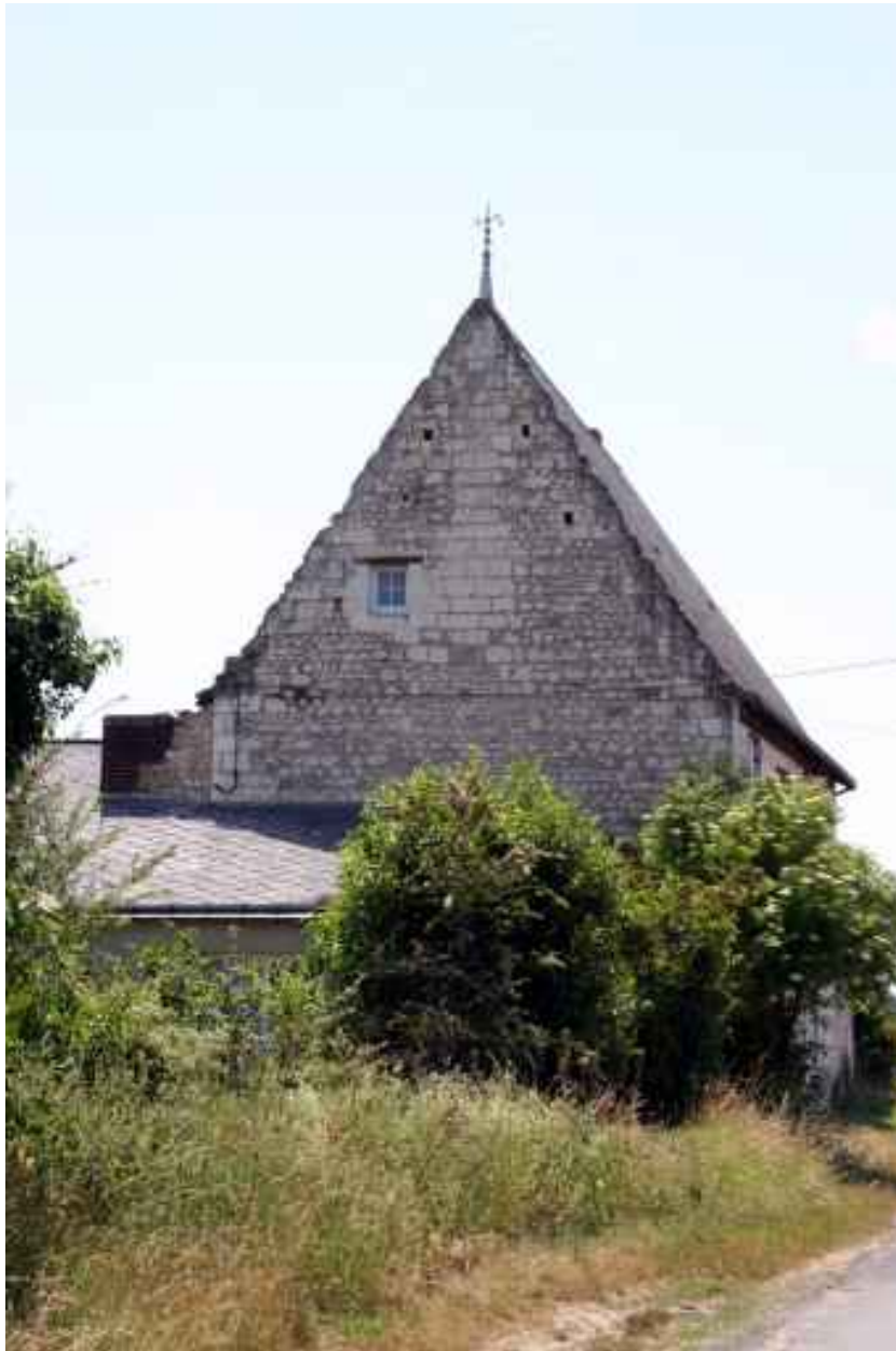
Vue de volume : pignon E.
