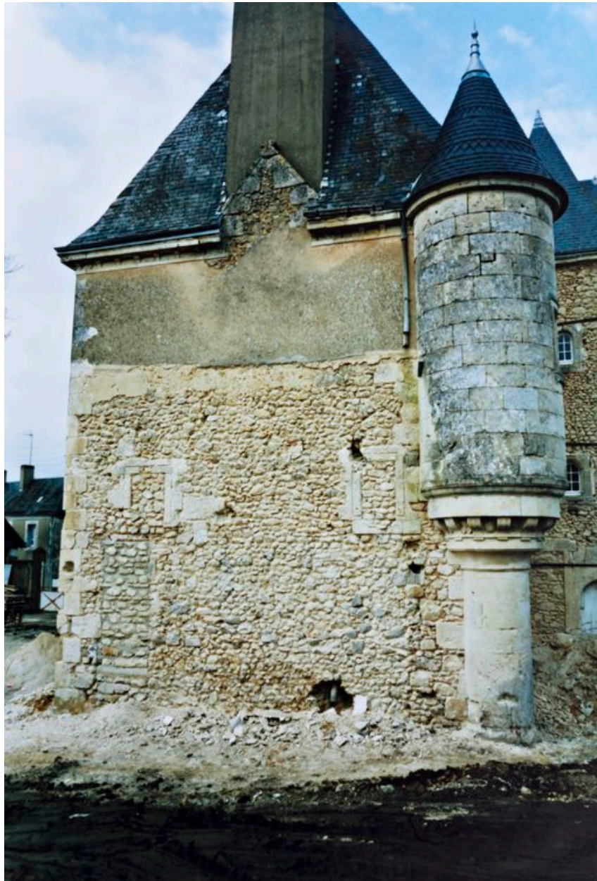
Logis, mur-pignon ouest : état pendant la restauration de 2008
