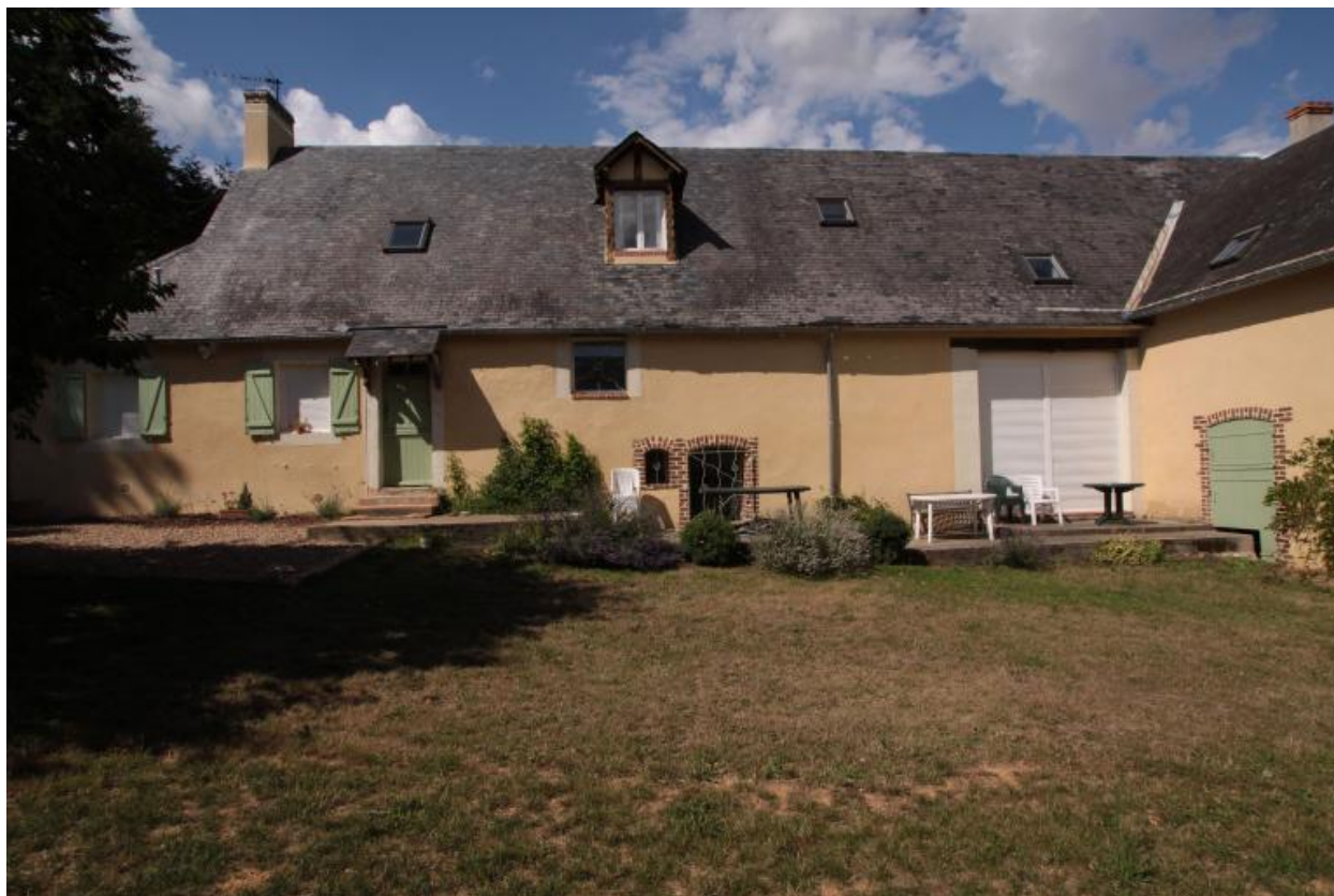
Maison et anciennes dépendances : façade sur cour.
