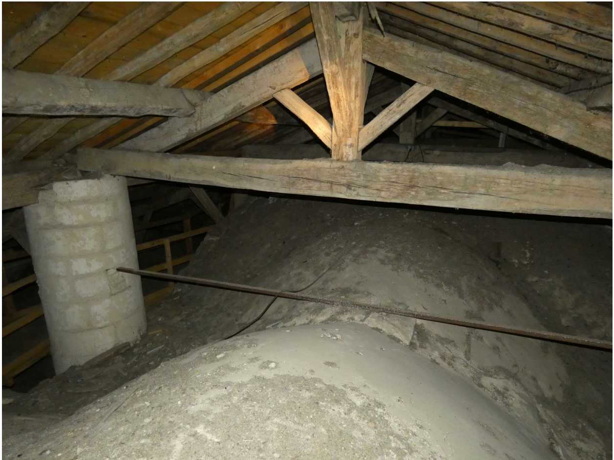
Les voûtes de la nef et la charpente.
