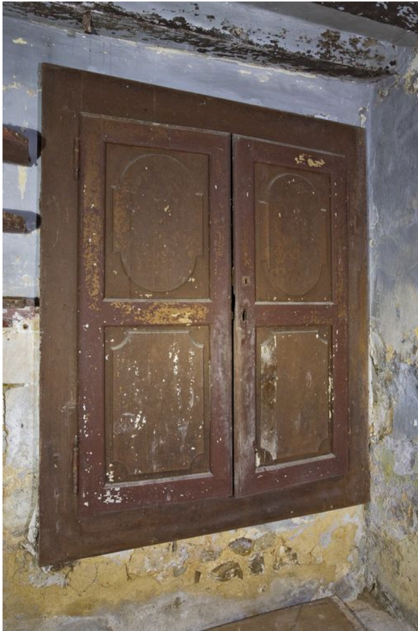
Cuisine de l'aile ouest : placard du mur ouest.
