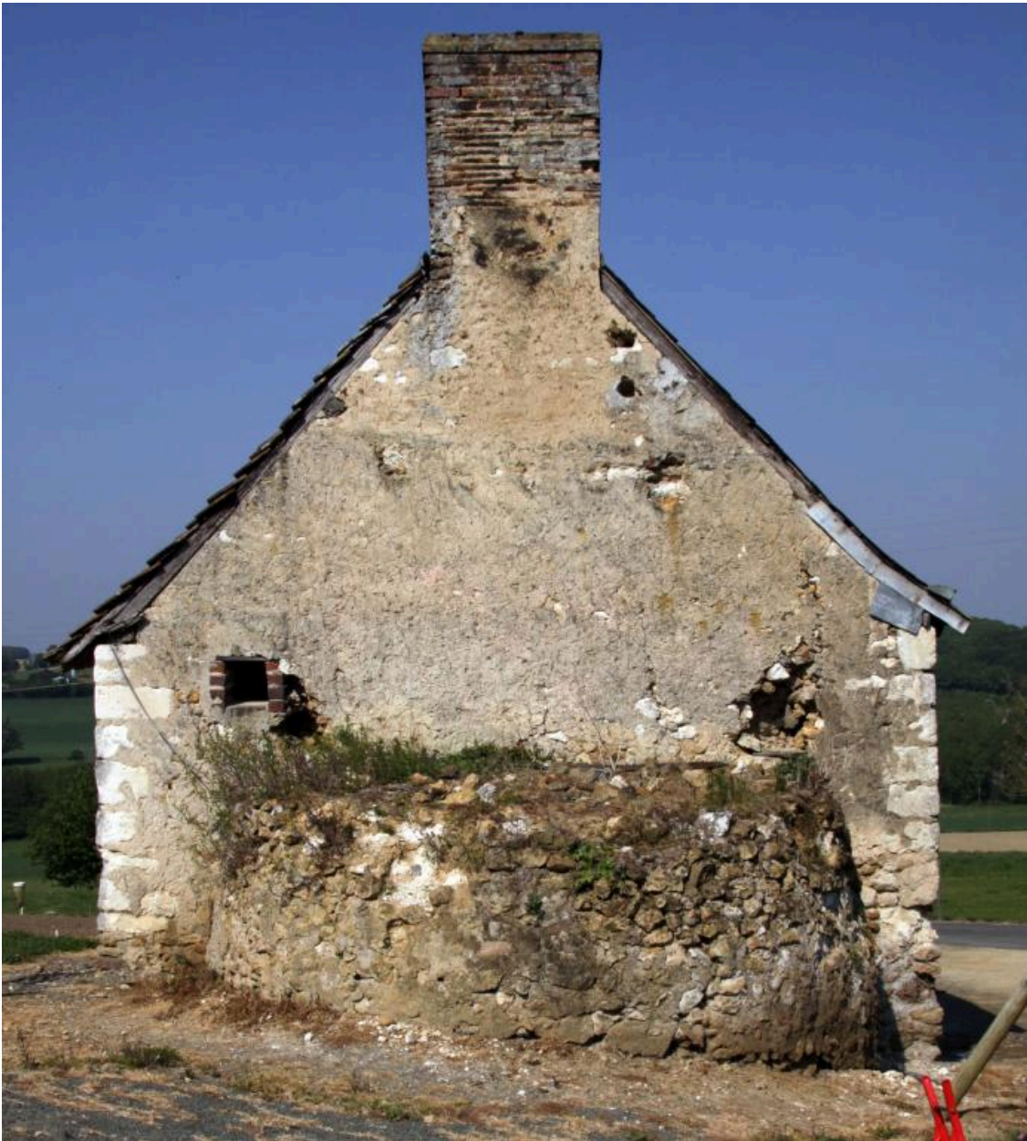
Four à pain accolé à la buanderie.
