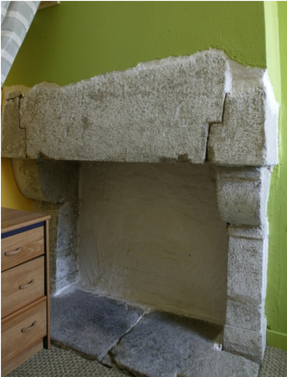
Cheminée nord du deuxième étage.
