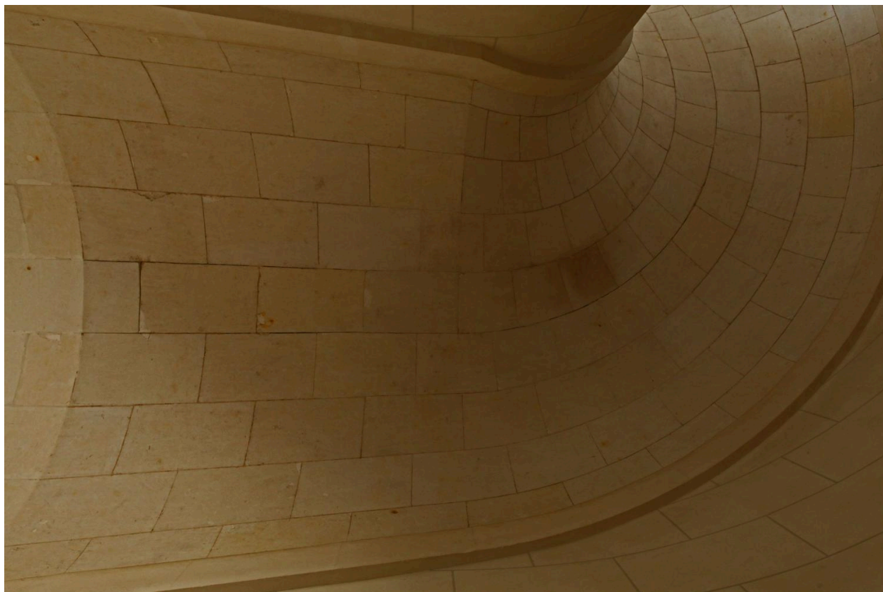
Escalier monumental, appareillage de la voute type voûte de type Saint-Giles.
