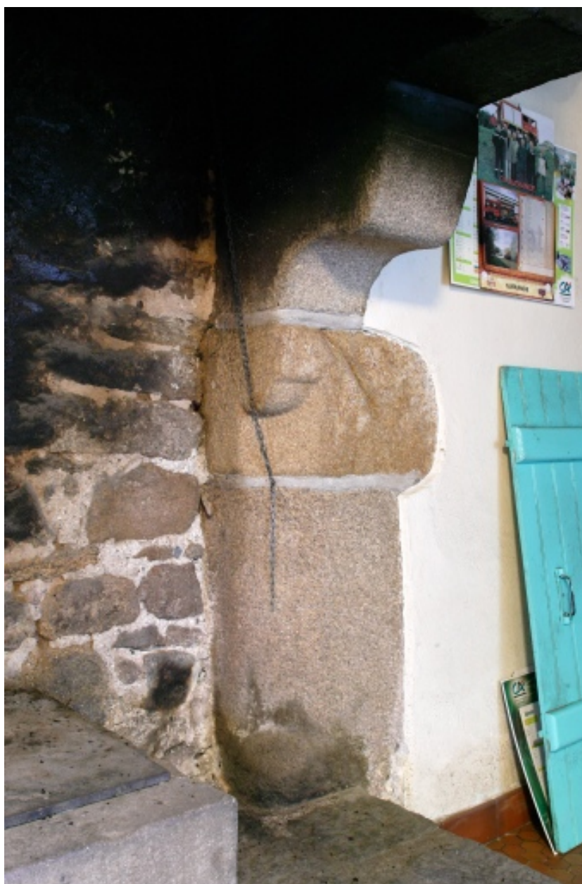
Cheminée, détail du piédroit droit.
