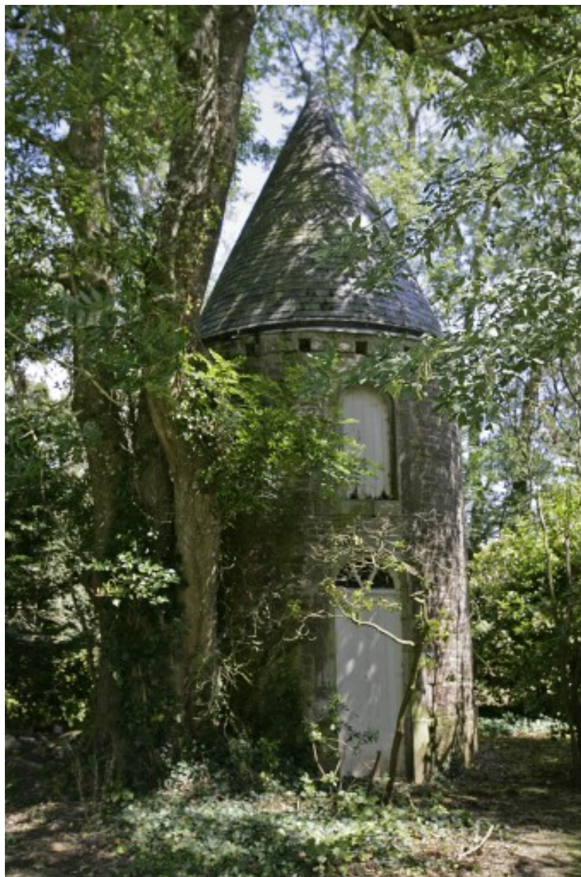
La partie subsistante de la chapelle.
