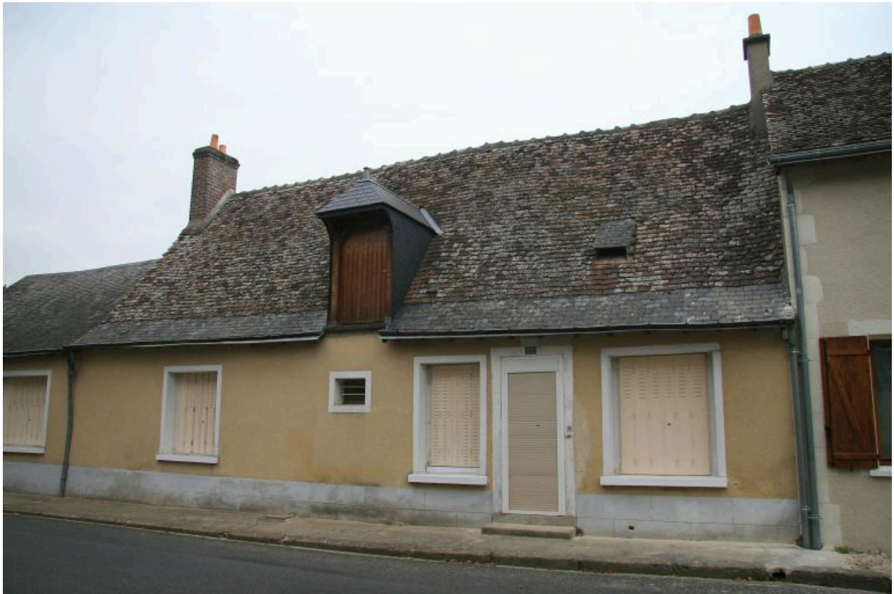
22, rue Principale : maison de type rural très remaniée.
