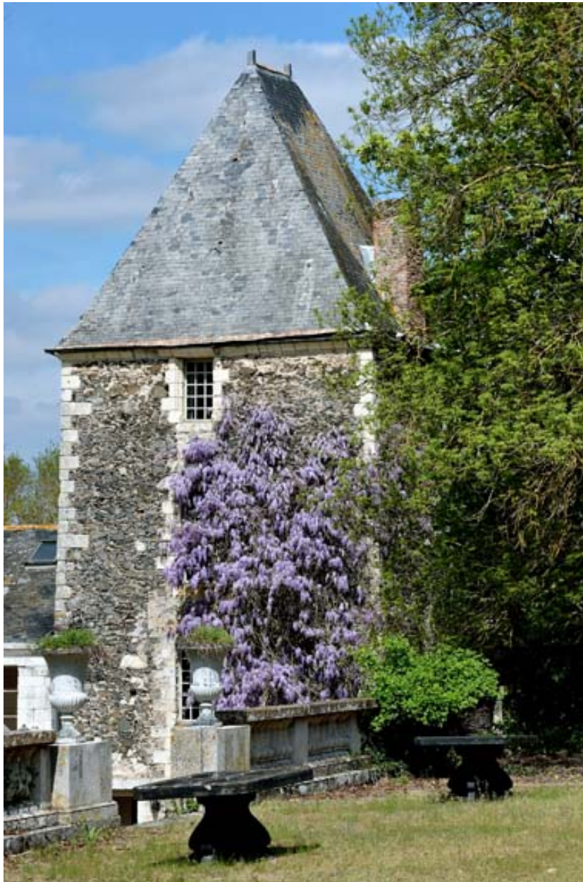
Mantelon. Château. Vue du châtelet d'entrée depuis le sud.
