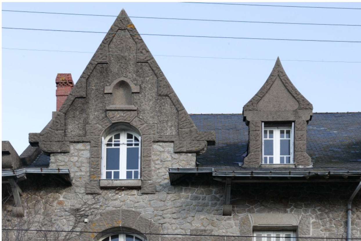
Détail lucarnes ouest.
