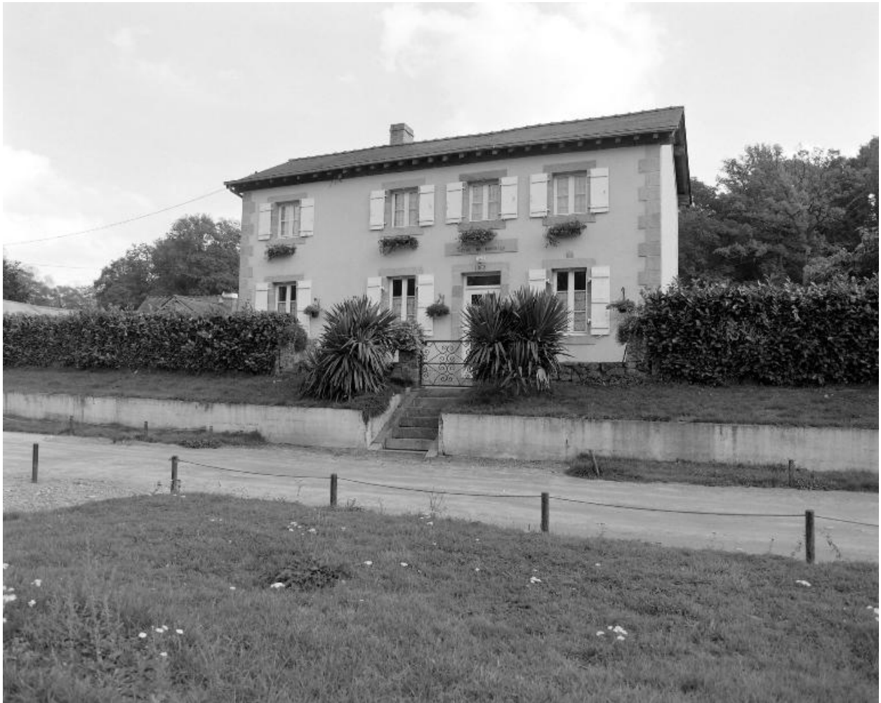
La maison éclusière.
