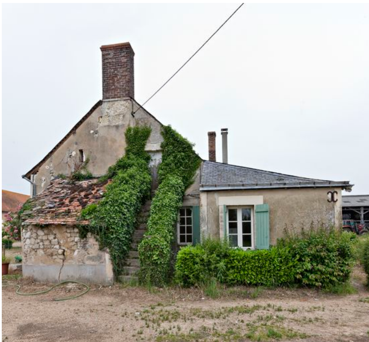
La maison d'habitation : le pignon avec le four.
