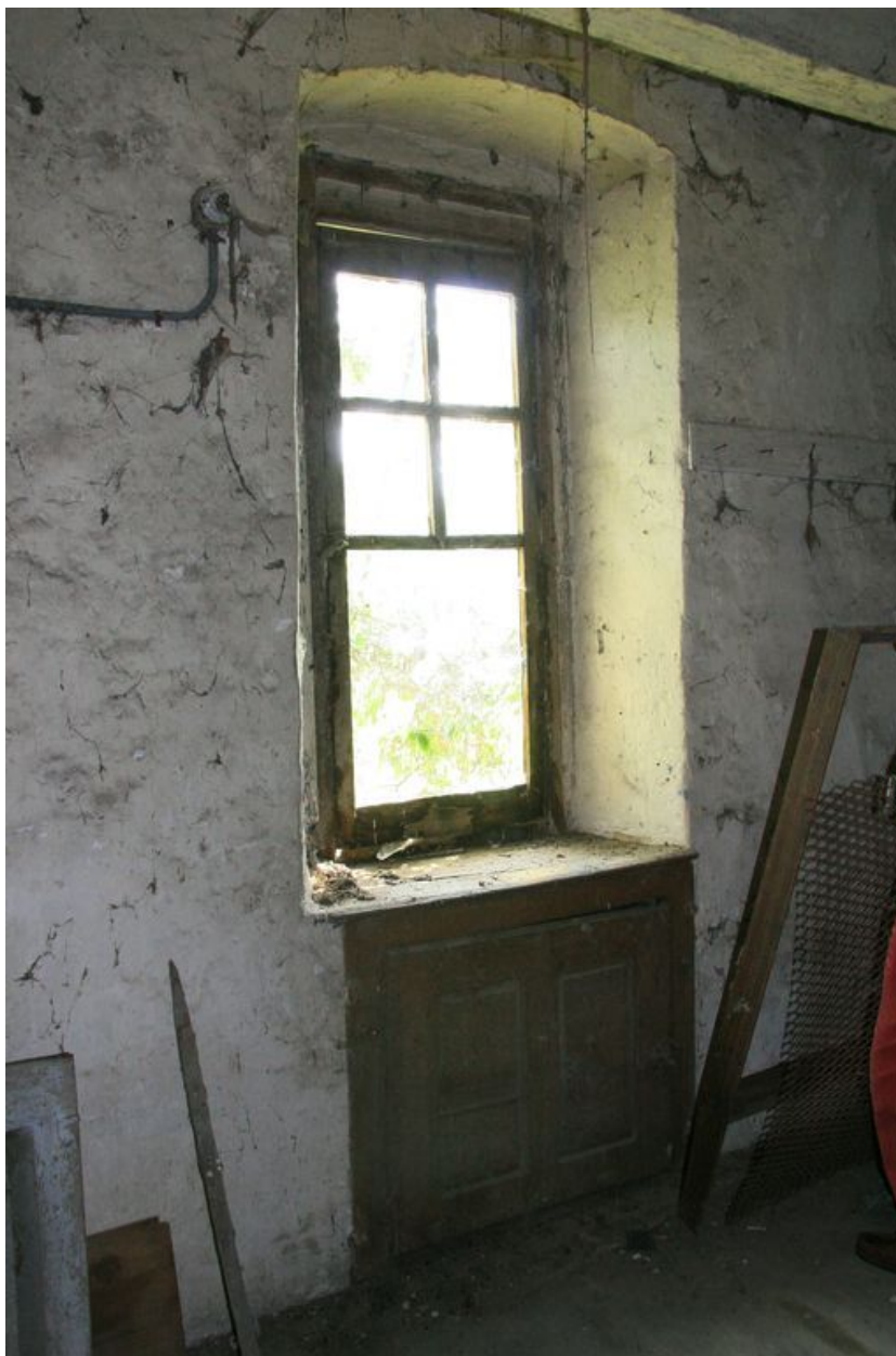
Maison attenante au potager : fenêtre et placard de la chambre.
