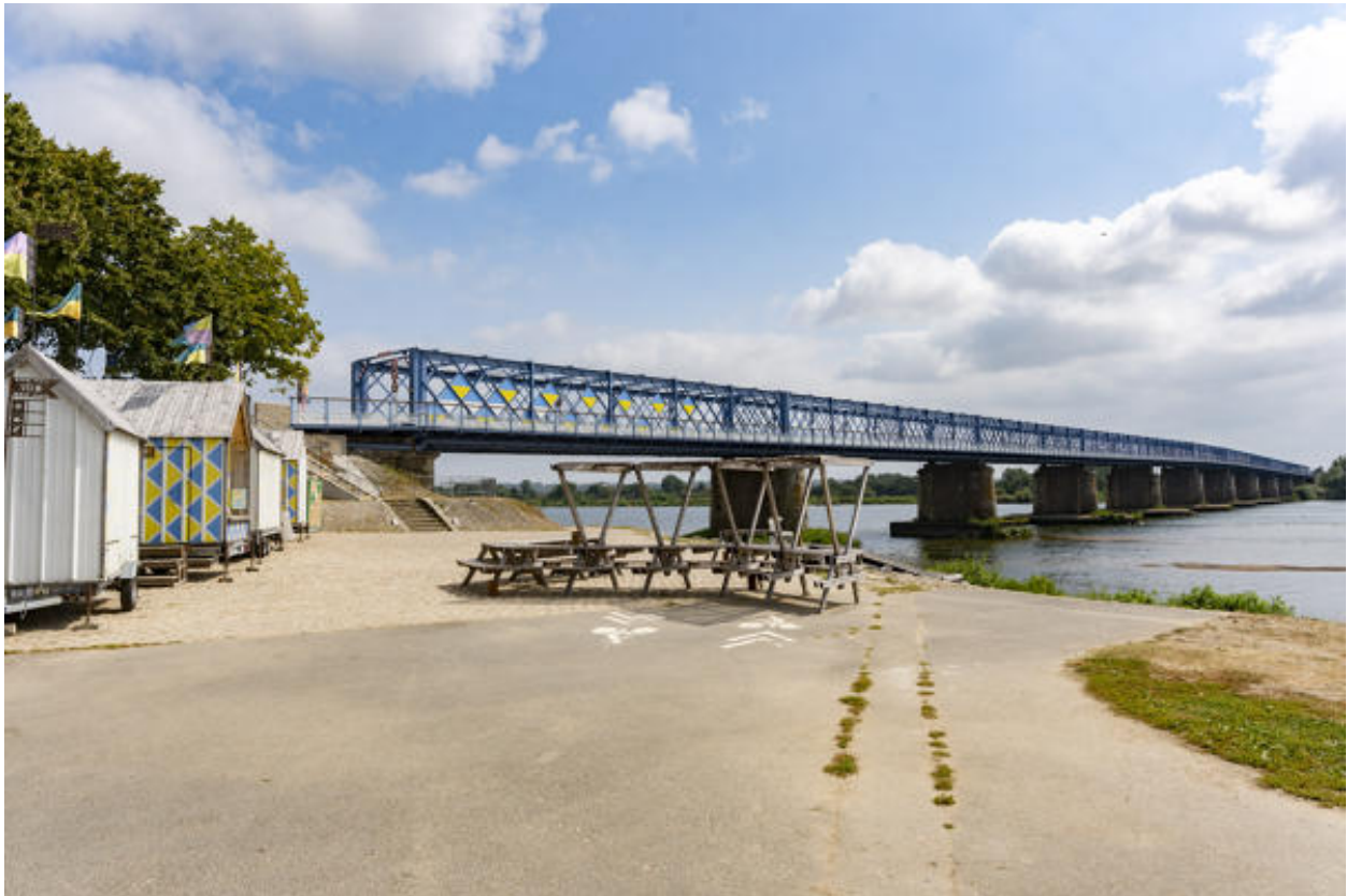
Vue générale de la cale aval.
