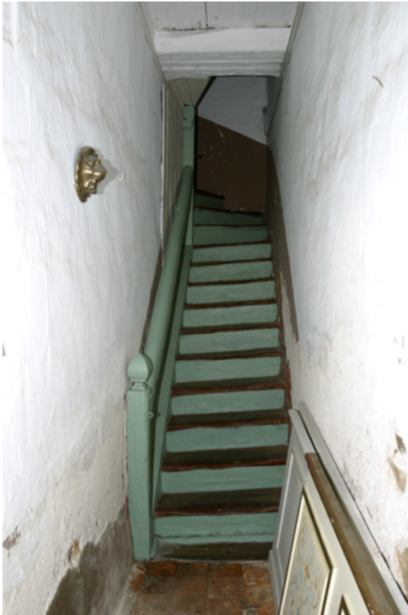
Vue de l'escalier prise depuis la porte d'entrée à droite.
