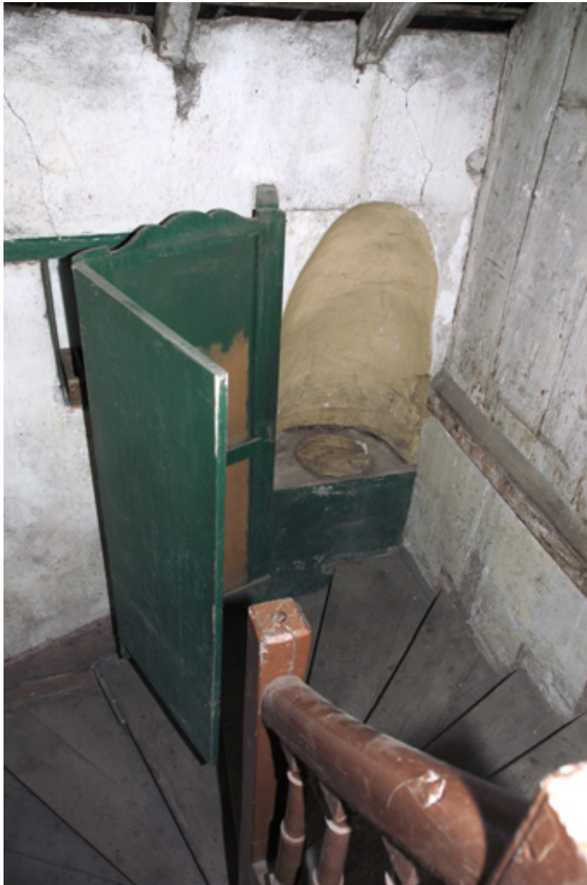
L'escalier, détail des latrines.
