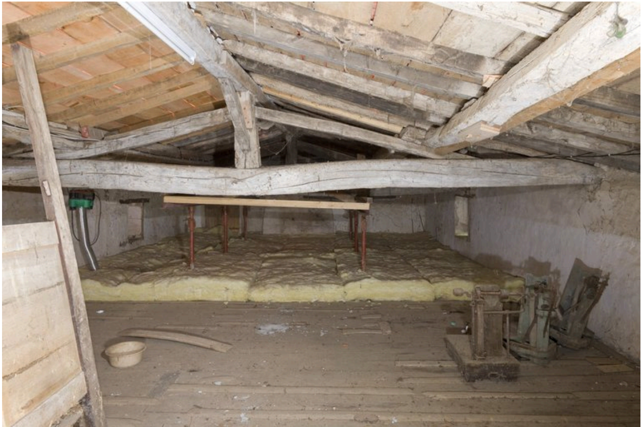
Charpente de la maison.
