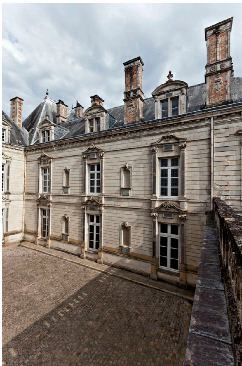
Façade de l'aile sud sur la cour.
