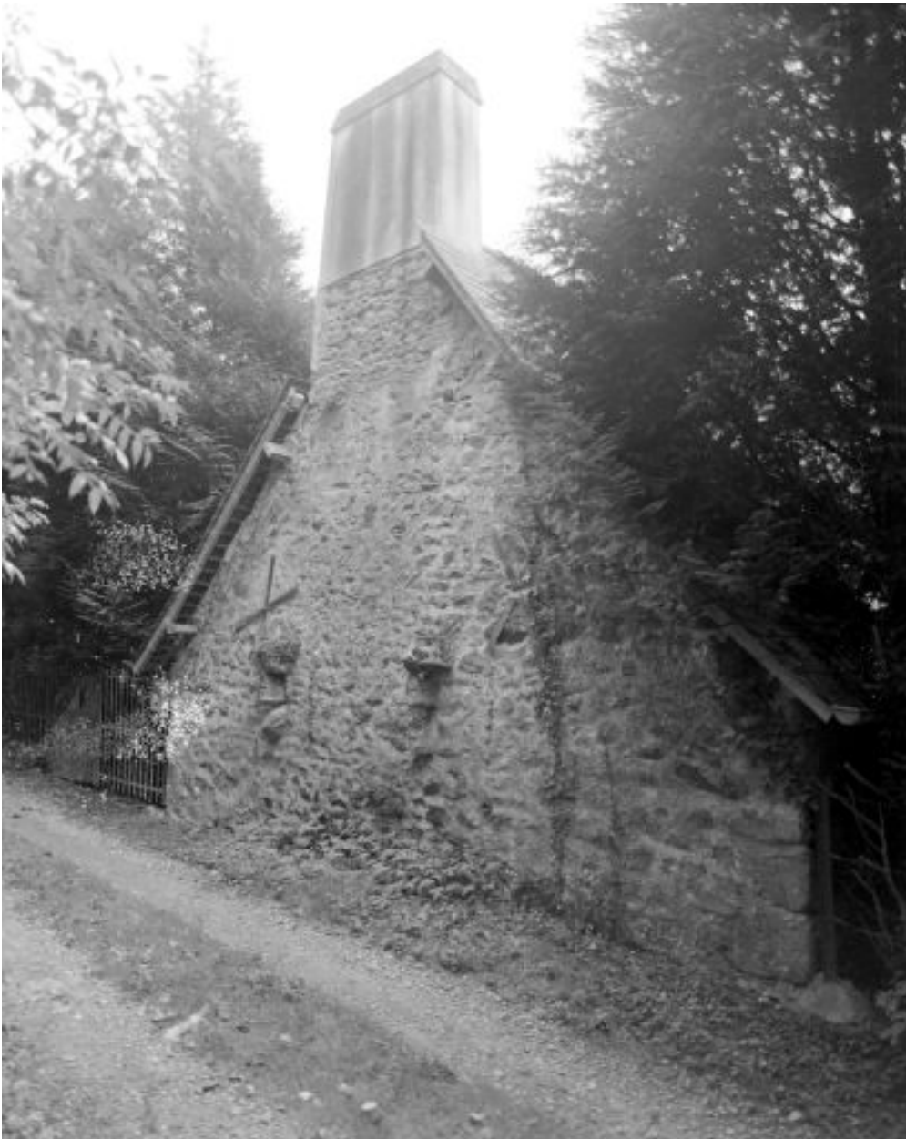
Pignon du bâtiment qu'occupait le logement du meunier.
