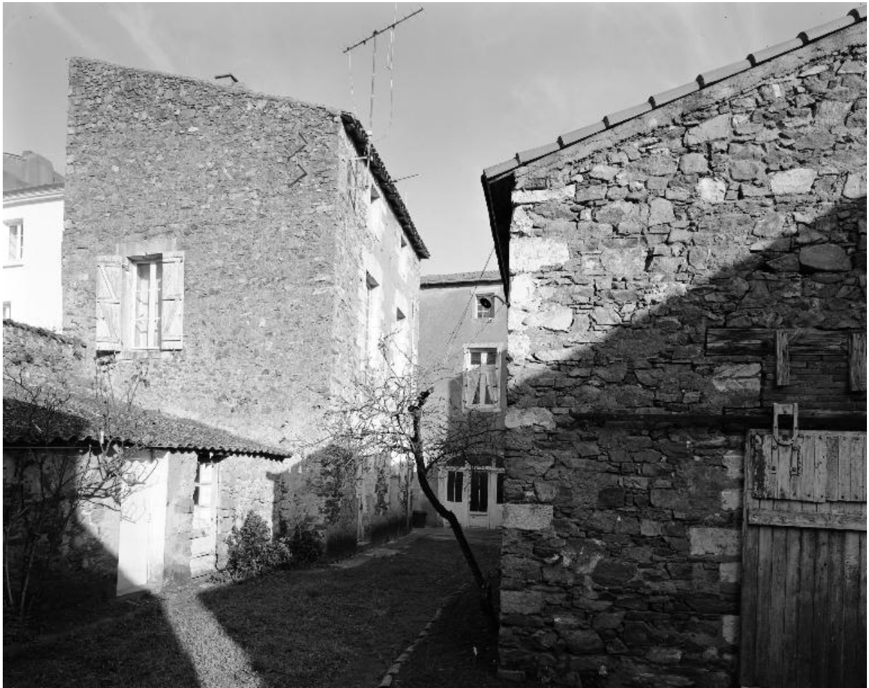
La façade postérieure de la maison n° 15 rue Pierre-Jubau.
