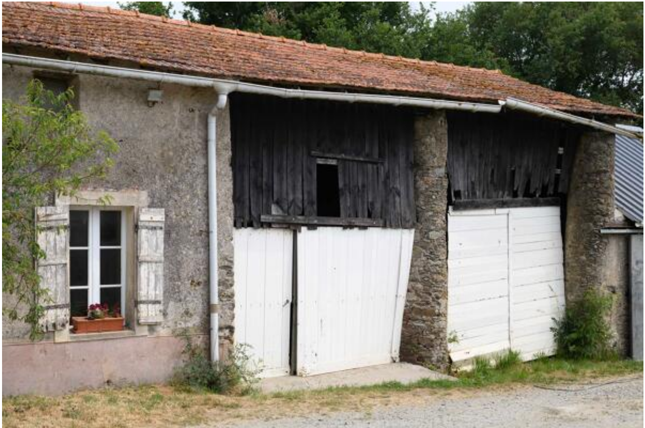
Détail de la grange à piliers ronds accolée au logis de la Petite Touche Fleury.
