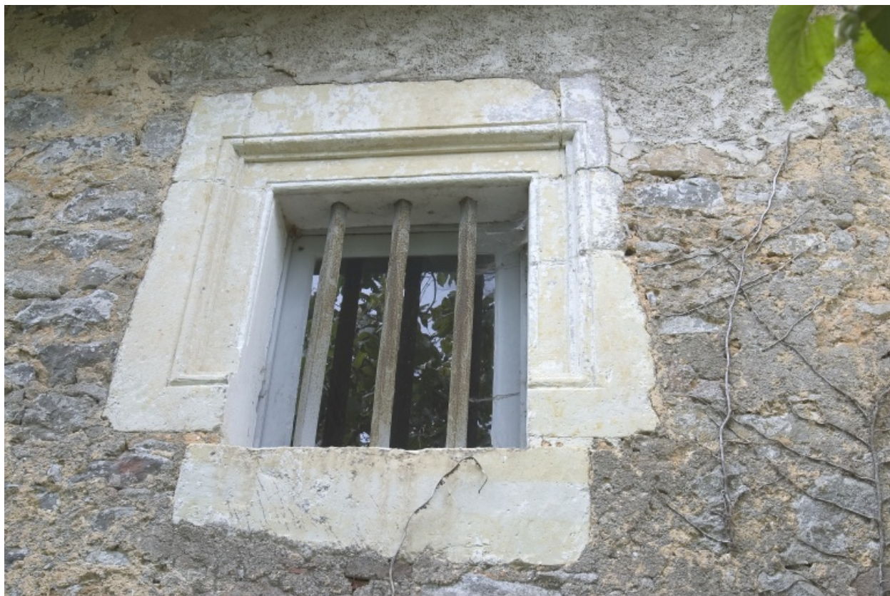
Détail de la façade postérieure de la partie est du bâtiment principal : fenêtre gauche.
