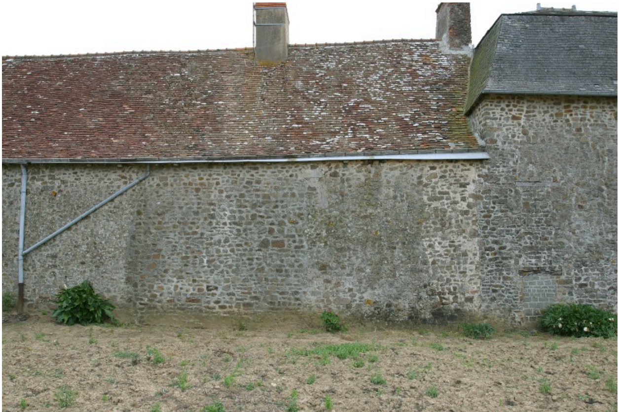
L'élévation postérieure du logis : partie centrale.
