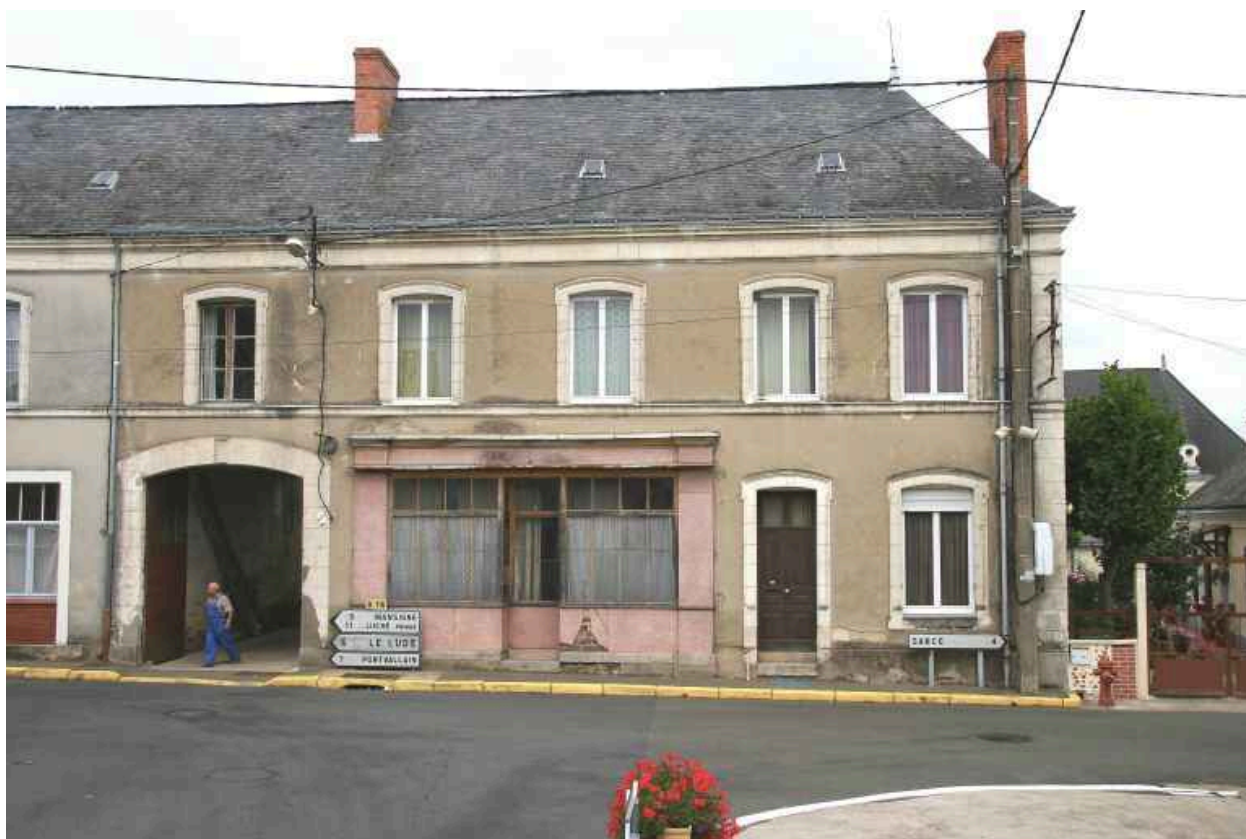
4-6, rue Saint-Hubert : façade sur rue avec un passage couvert.
