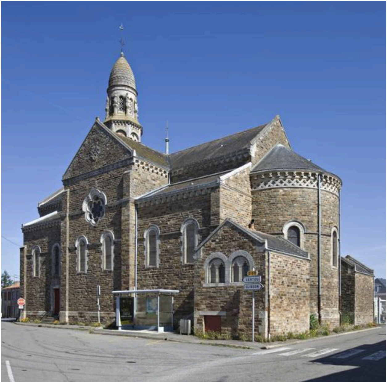
L'élévation sud, flanquée de la seconde sacristie édiflée en 1898.
