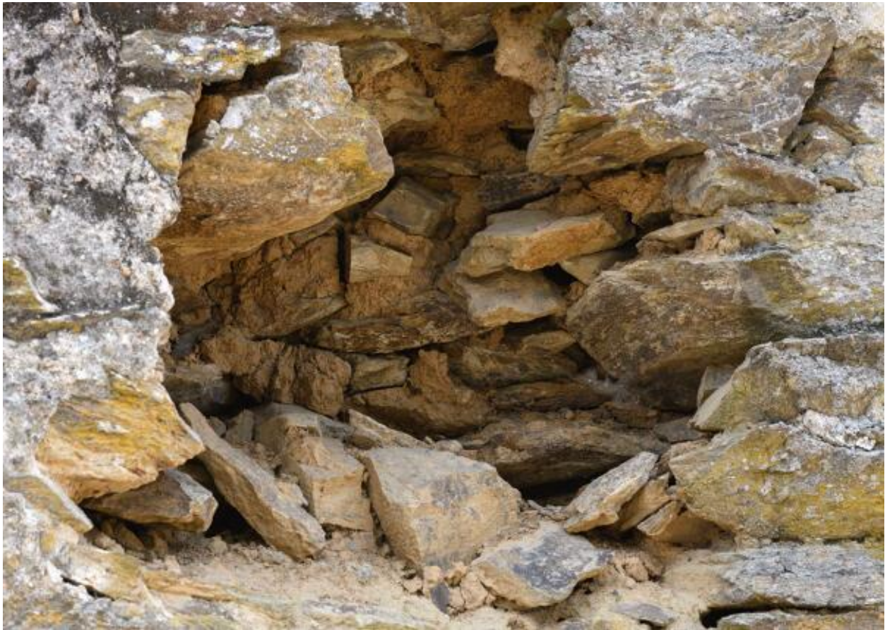
Détail de la composition du pignon nord de l'étable de la Petite Touche Fleury (moellons de schiste avec mortier de terre).
