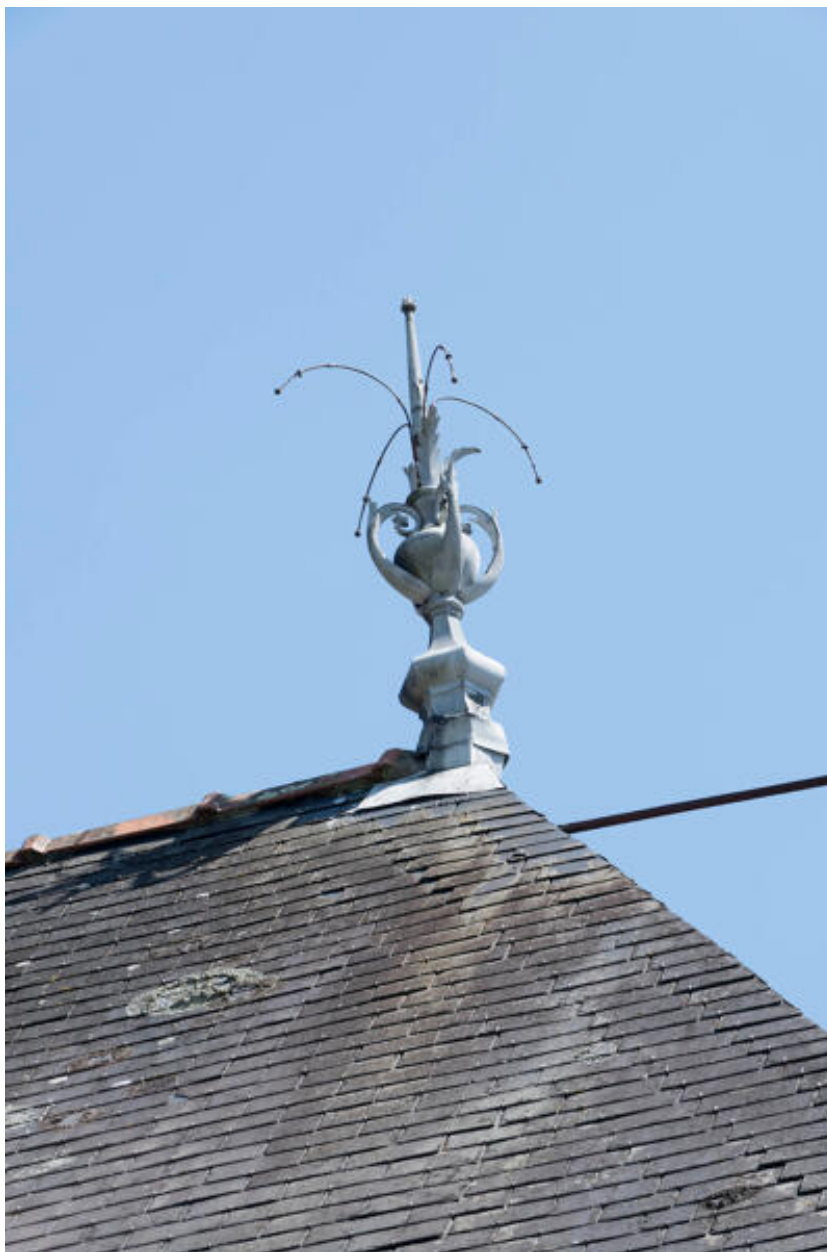
Détail de l'épi de faîtage.
