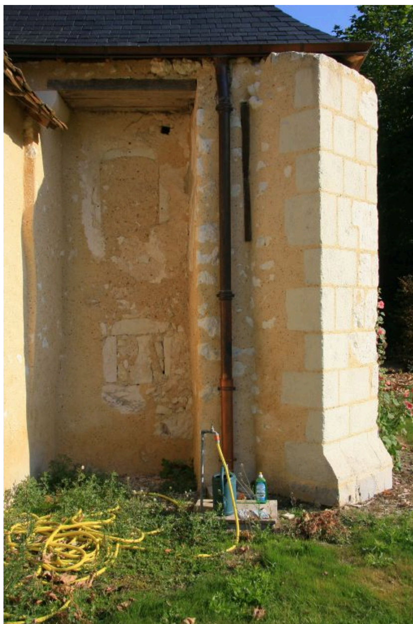
La chapelle : contrefort de l'angle sud-ouest.
